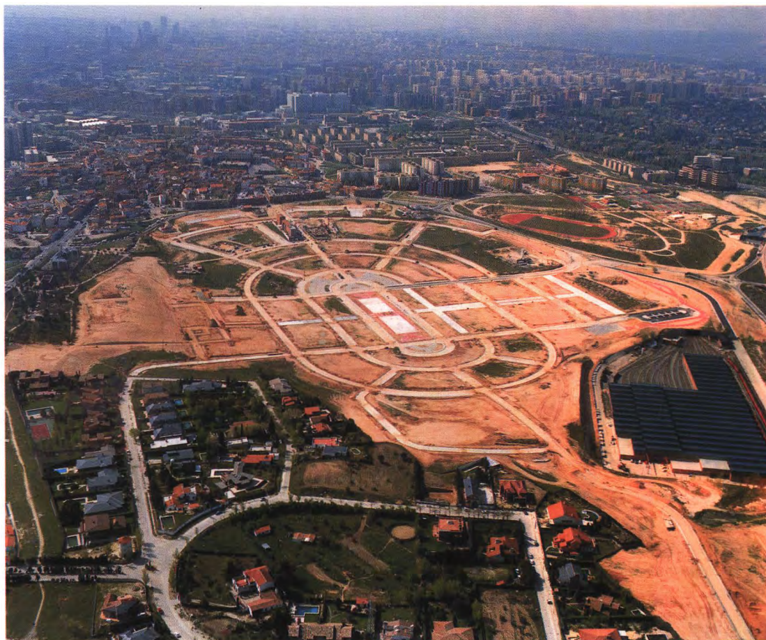
Estado actual de la urbanización.
