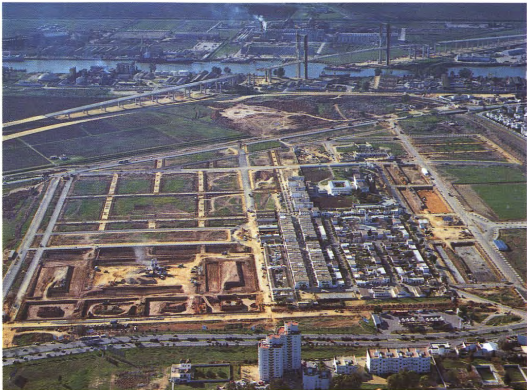
Situación de ejecución del Sector Norte. Junio 1991.
